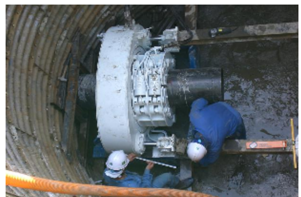
鋼管固定作業完了
