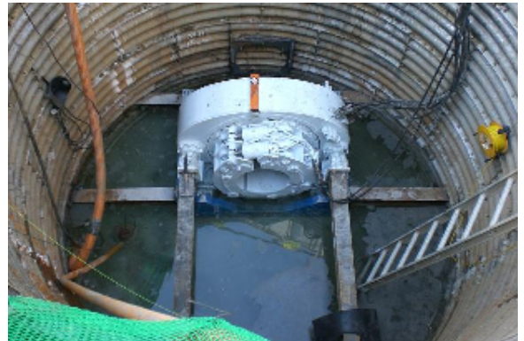
推進機固定作業完了
