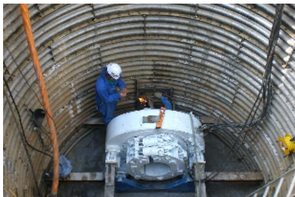
坑口・止水器取付作業状況
