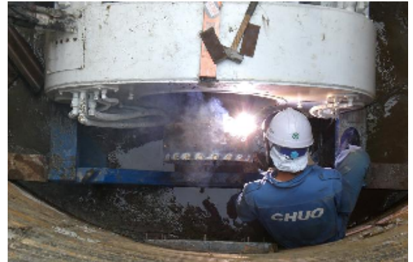
推進ビット取付作業状況
