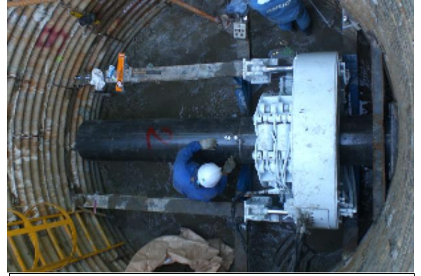
鋼管溶接作業完了
