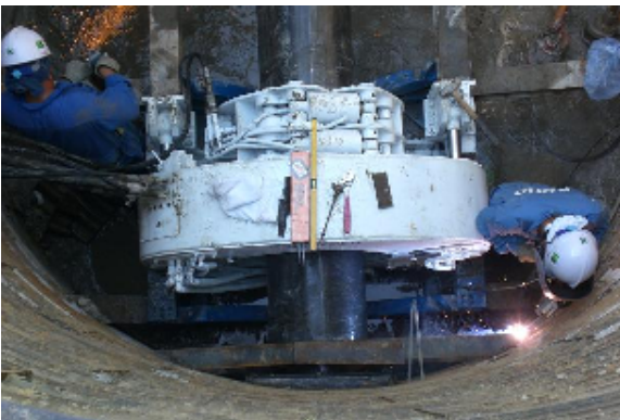
鋼管固定作業状況
