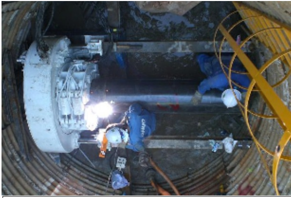
鋼管溶接作業状況
