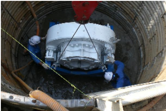
推進機吊降り据付作業状況
