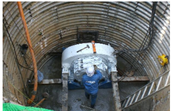
坑口・止水器取付作業状況
