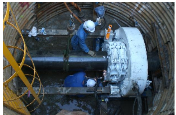
2本目鋼管吊り込みセット状況
