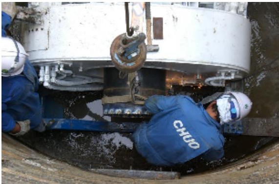
推進ビット取付作業状況
