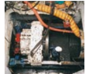
横浜市公共下水道φ1,500mm削進工
