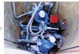
3 計測装置により方向を確認し、方向修正を行ないながら、埋設管を順次推進してゆきます。
