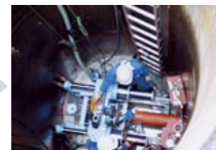
7 ケーシングを引き抜き回収します。
