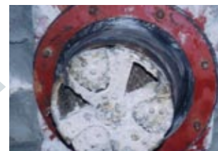
5 2~4の作業を繰り返し到達立坑に到達させます。
