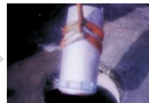
6 1号マンホールより4分割回収します。
