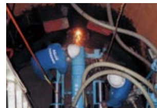
1 先導体を発進立坑に据付け、鏡切りを行ないます。
