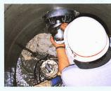
到達したら、到達坑よりオ ガーヘッド及び先導管 を回収します。
