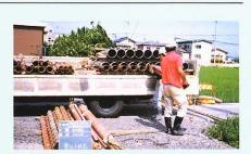
地上で埋設管内に、ケーシング及びス クリューをセットし、坑内に降ろして接 続します。
