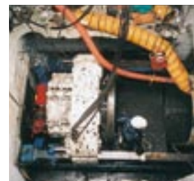
横浜市公共下水道φ1,500mm削進工
