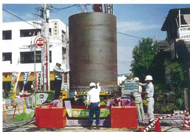
先端ケーシング建込
