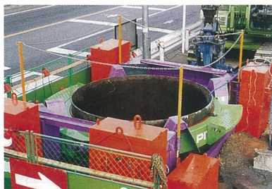
揺動圧入状況
